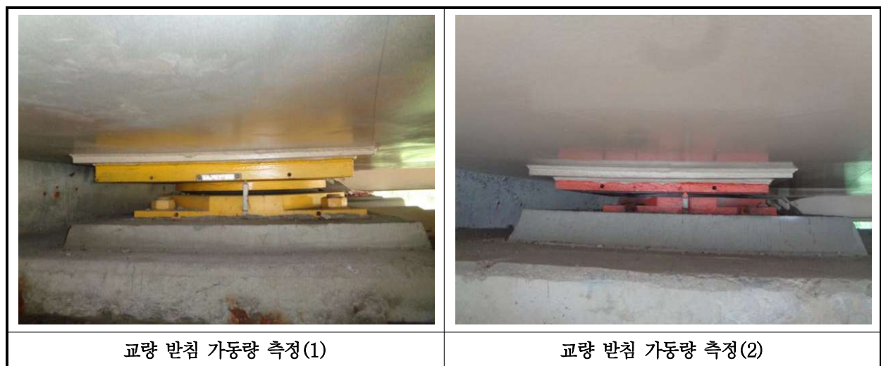
【사진 15.3.13】교량받침 이동량 측정
