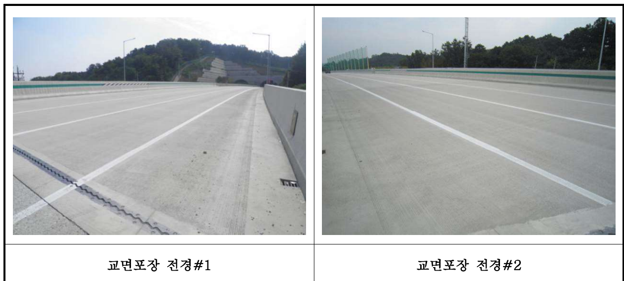
【사진 15.3.17】 교면포장 전경
