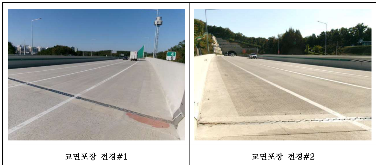
【사진 15.3.38】 교면포장 전경
