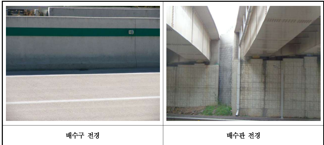
【사진 15.3.40】 배수시설 전경
