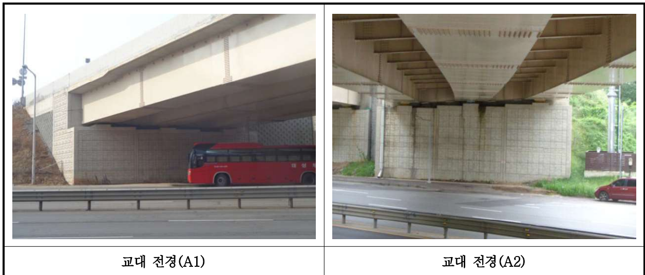
【사진 15.3.29】 교대 전경
