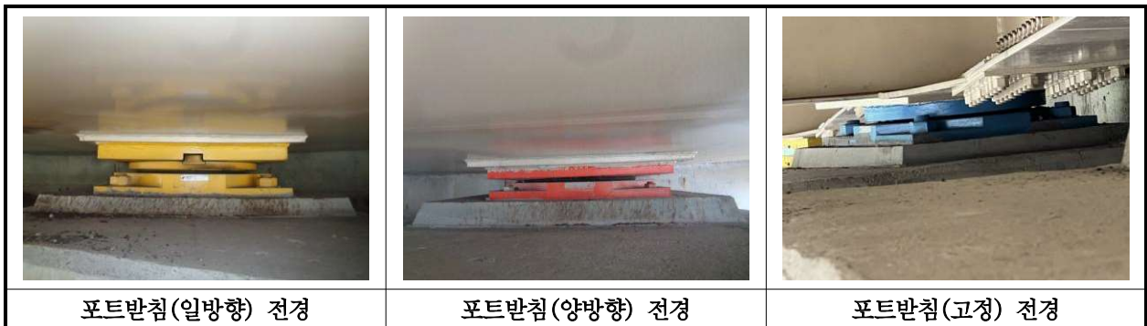
【사진 15.3.10】 교량받침 전경
