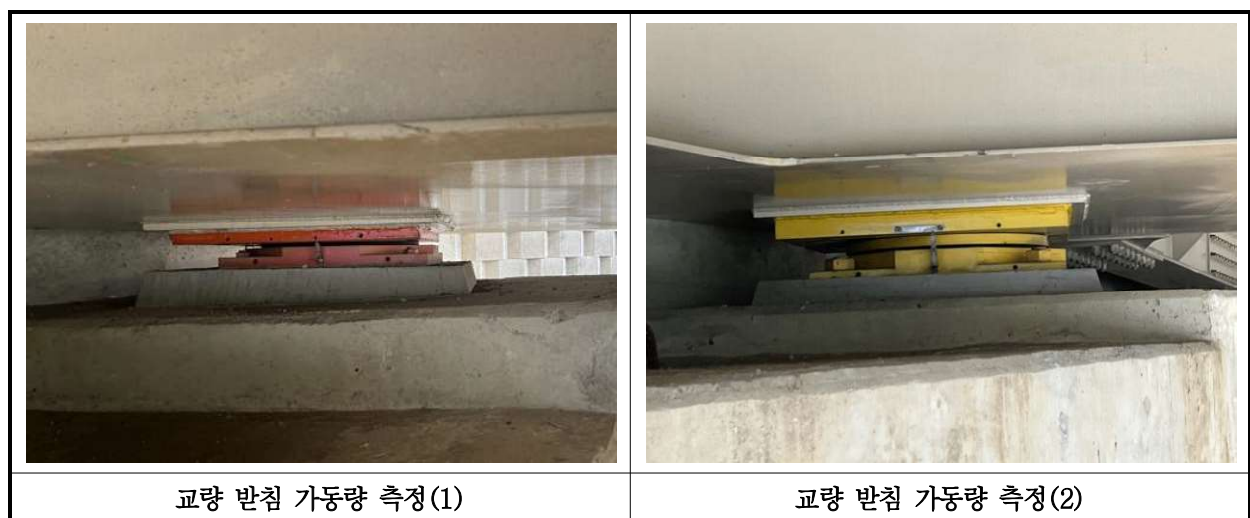
【사진 15.3.34】 교량받침 이동량 측정
