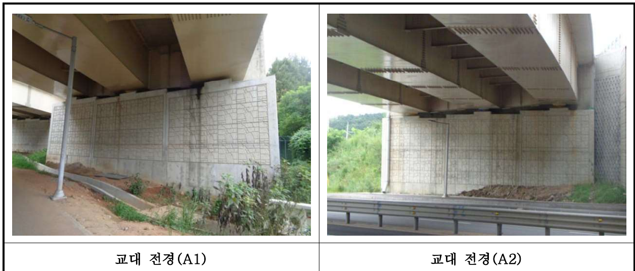
【사진 15.3.8】 교대 전경
