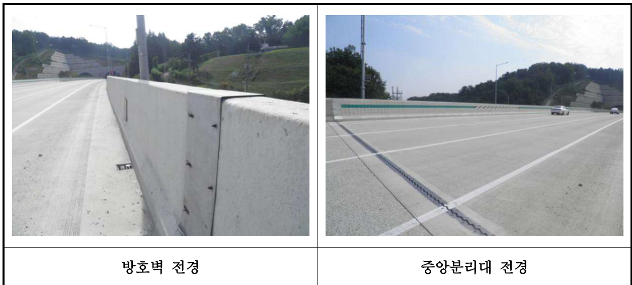
【사진 15.3.21】 방호벽 및 중앙분리대 전경
