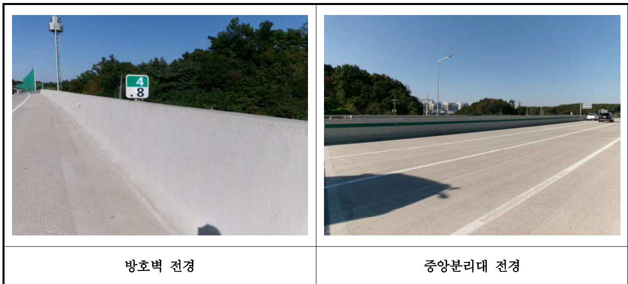
【사진 15.3.42】 방호벽 및 중앙분리대 전경
