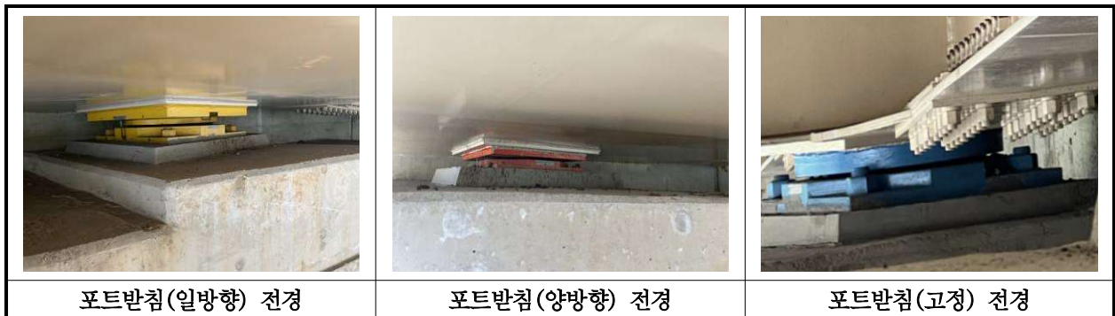
【사진 15.3.31】 교량받침 전경
