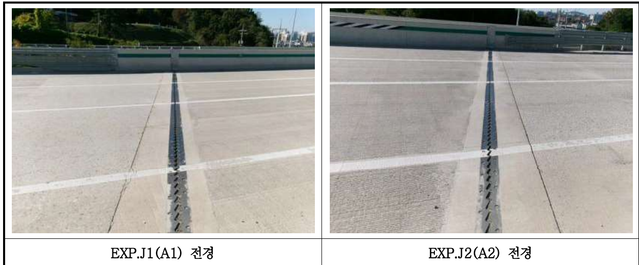
【사진 15.3.35】 신축이음장치 전경
