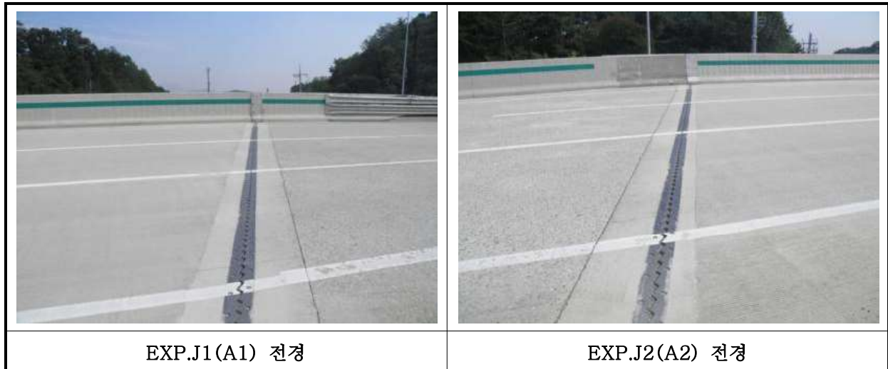
【사진 15.3.14】 신축이음장치 전경
