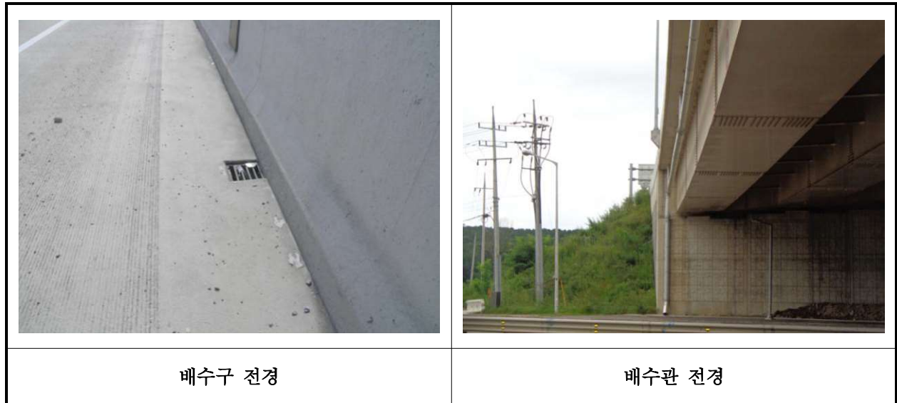
【사진 15.3.19】 배수시설 전경
