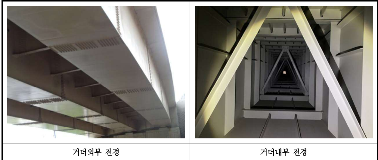
【사진 15.3.4】 거더 전경
