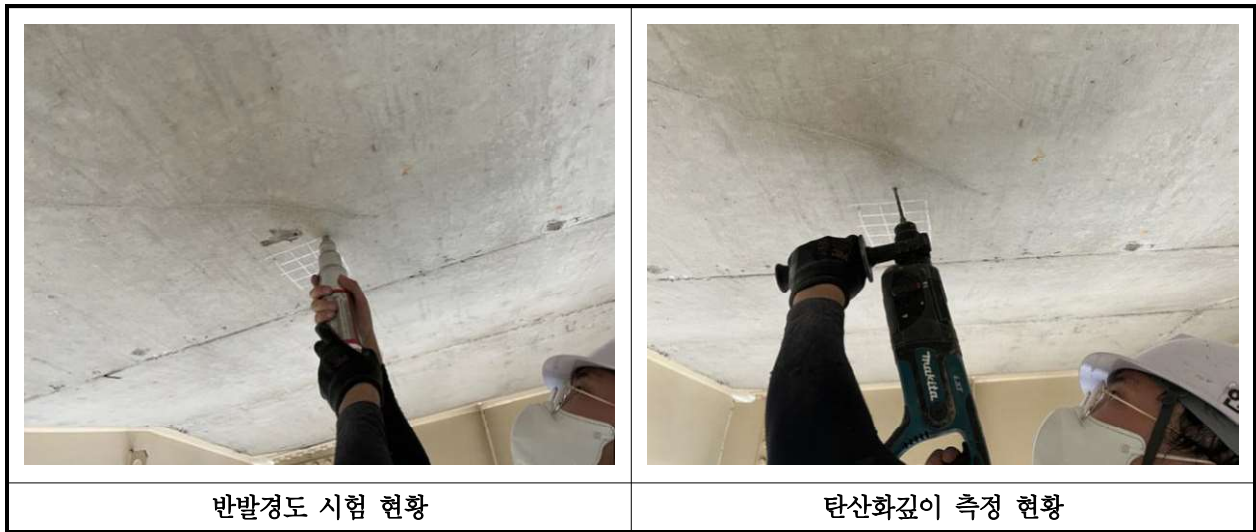
【사진 15.4.1】 콘크리트 내구성조사 현황
